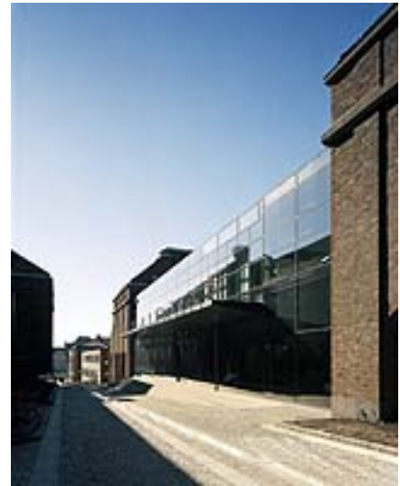
KTH:s bibliotek med glasfasad. Foto: Åke E:son Lindman.
