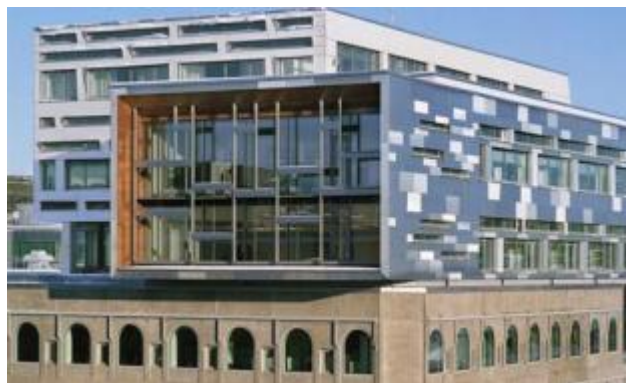
Fig. 5 Den färdiga påbyggnaden i kv Loen.
