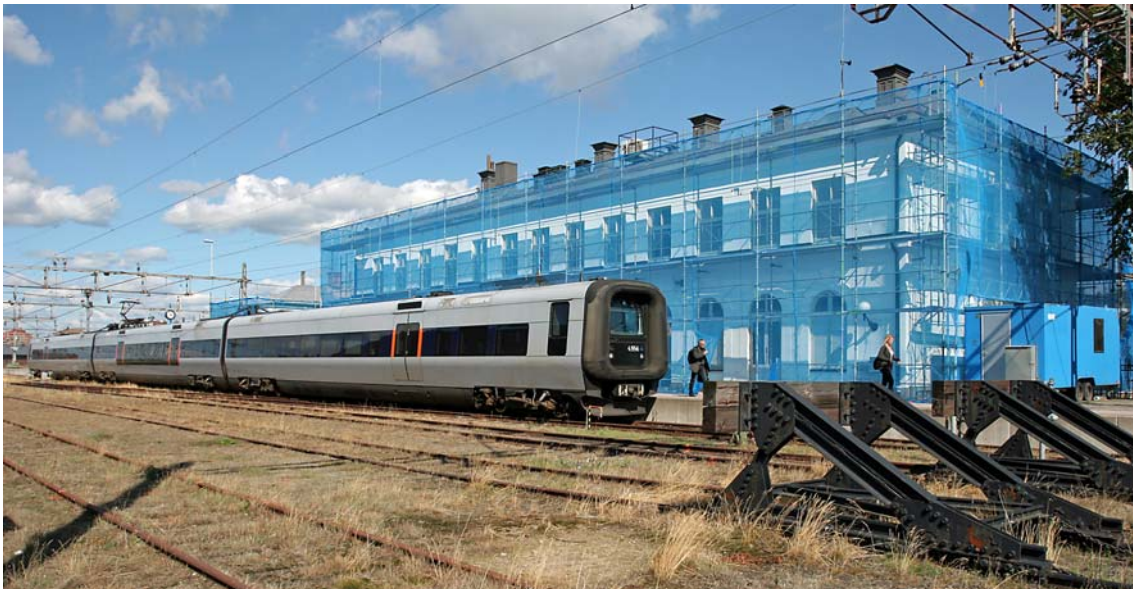
Figur 42. Stationshuset i Karlskrona C under renovering i augusti 2008. Foto: Oskar Fröidh
