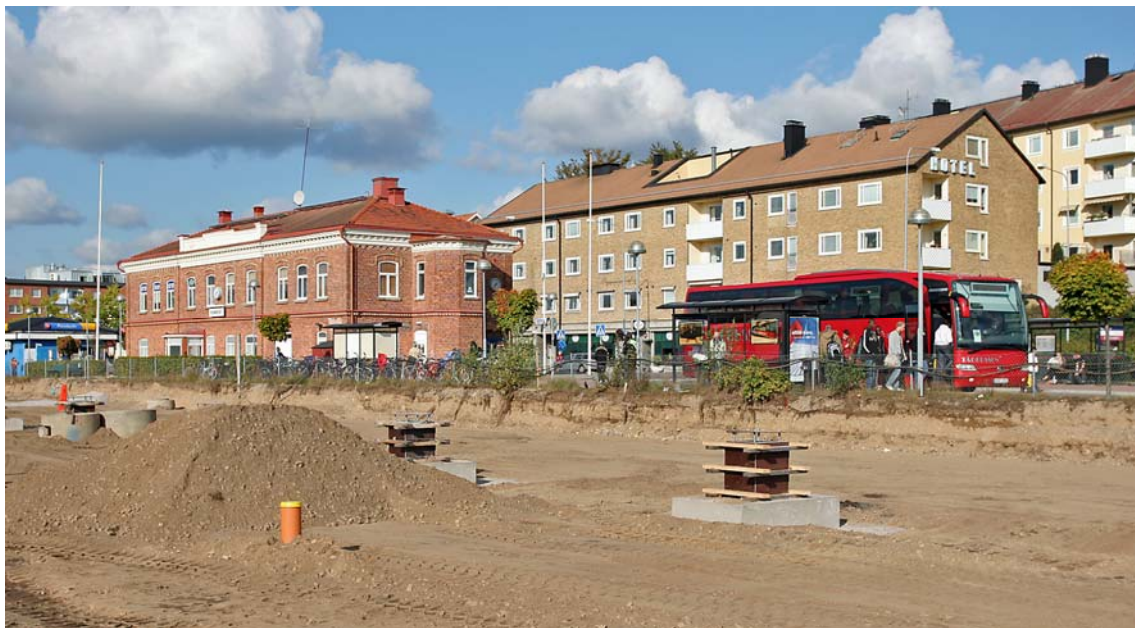
Figur 5. Ronneby station under ombyggnad med alla spårerna borttagna i oktober 2006. Den ersättande tågbusen gör uppehåll. Foto: Oskar Fröidh
