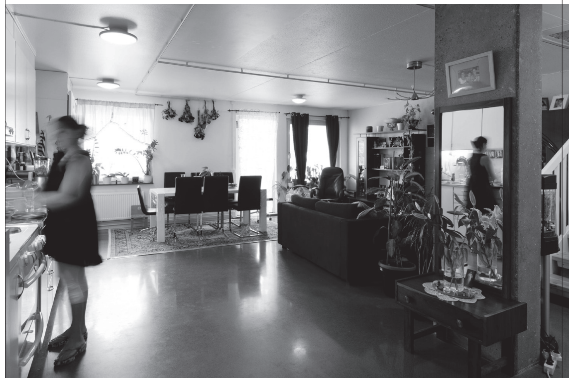
⑥筆者によって改築されたテンスタ地区の住戸。この事例では床スラブを抜くことによって上階とつなぎ、メゾネット住宅として再生している
