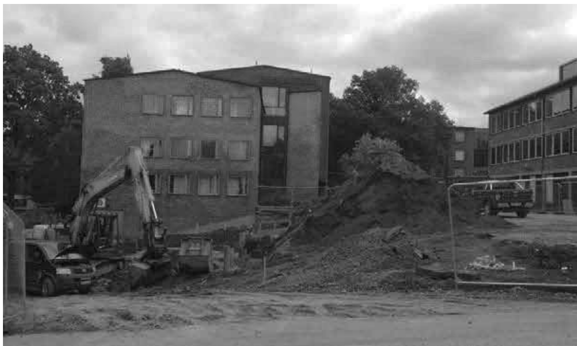
Fig. 1. Strategisk placering av schaktmassor alldeles utanför de installerade rören för sponten. Grävmaskinen i bilden schaktar innanför rörsponten som går strax till höger om skopan i bilden.
