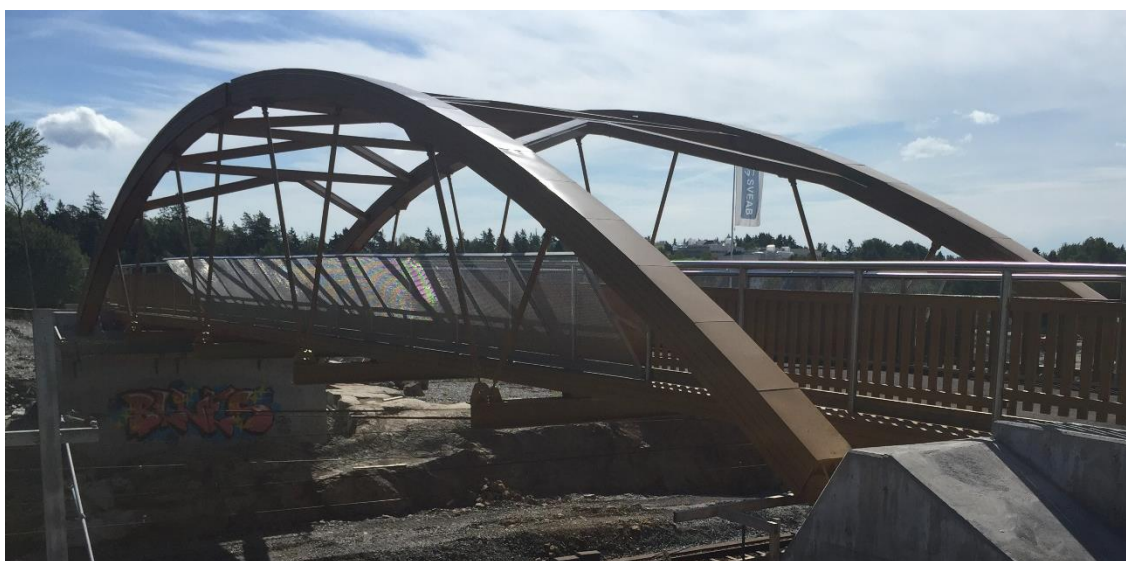
Gång- och cykelbro i Haninge (Vegabron), uppförd under 2017. Detta är ett exempel på en träbaserad hybridkonstruktion. Kombinationen av stål och trä möjliggör en slank konstruktion, med enkla och justerbara förband. Spännvidd ca 35 m. Bild: Eric Borgström.
