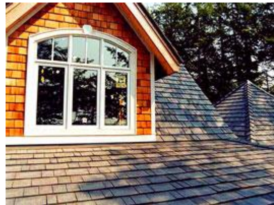
Fönster, dörrar, tak, panel
