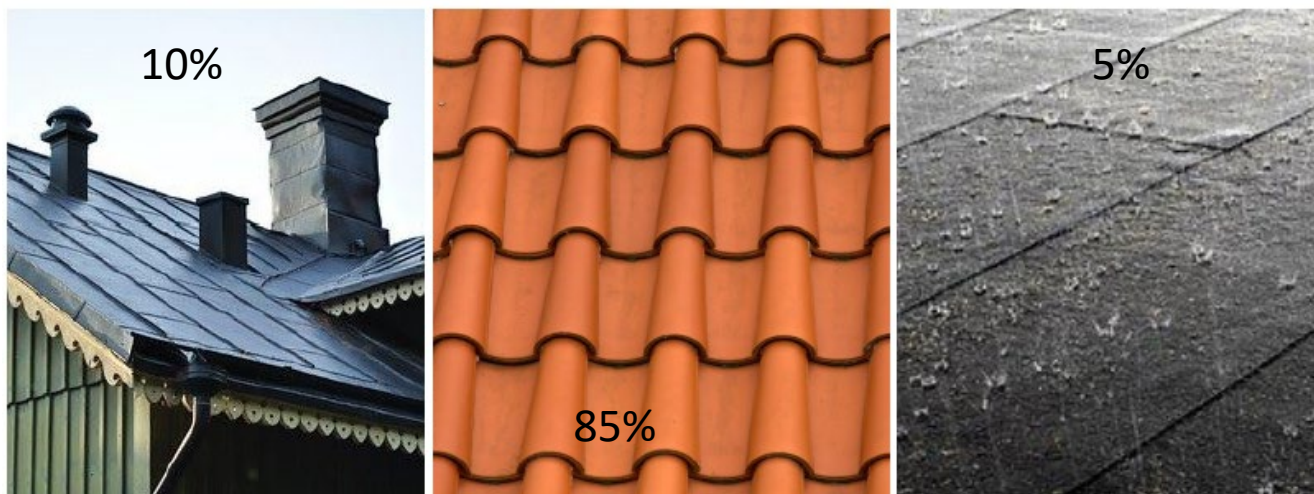
Olika typer av takbeklädnad. Plåt-, keramikpanne- och takpappstak. H. Simonsson (CC BY-SA 2.0), M. Vorel (CC0), W. Carter
