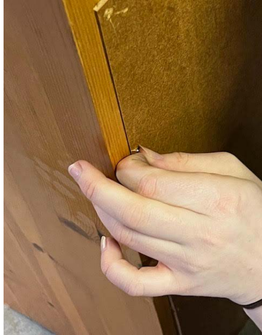
Bild 10: Borttagning av masonitskiva.
