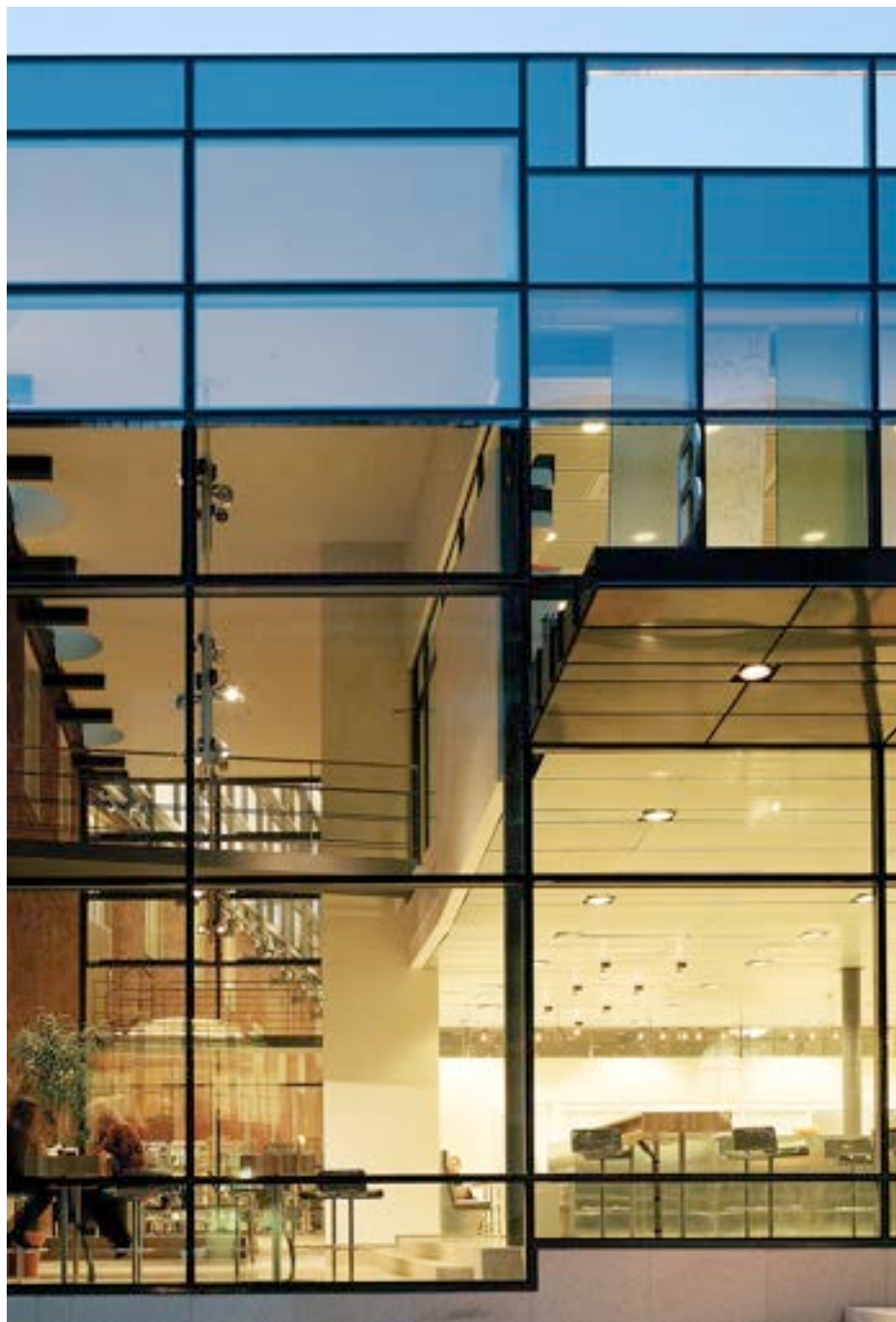
Bibliotekets fasad sedd från Osquars backe. Foto: Åke Eson Lindman.
