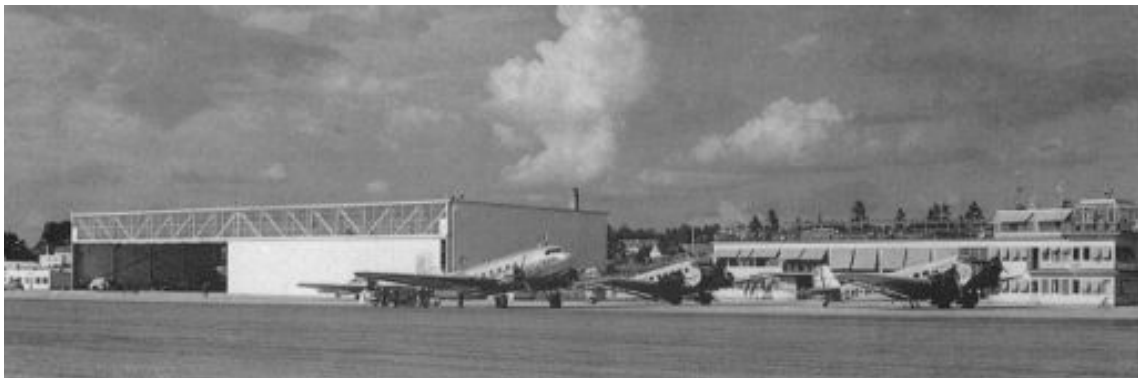
Bild 22: Paul Hedqvist; Hangaren och flygstationsbyggnaden från rampen, troligen sommaren 1937. Foto: C.A. Rosenberg, Arkitekturmuseets arkiv.
