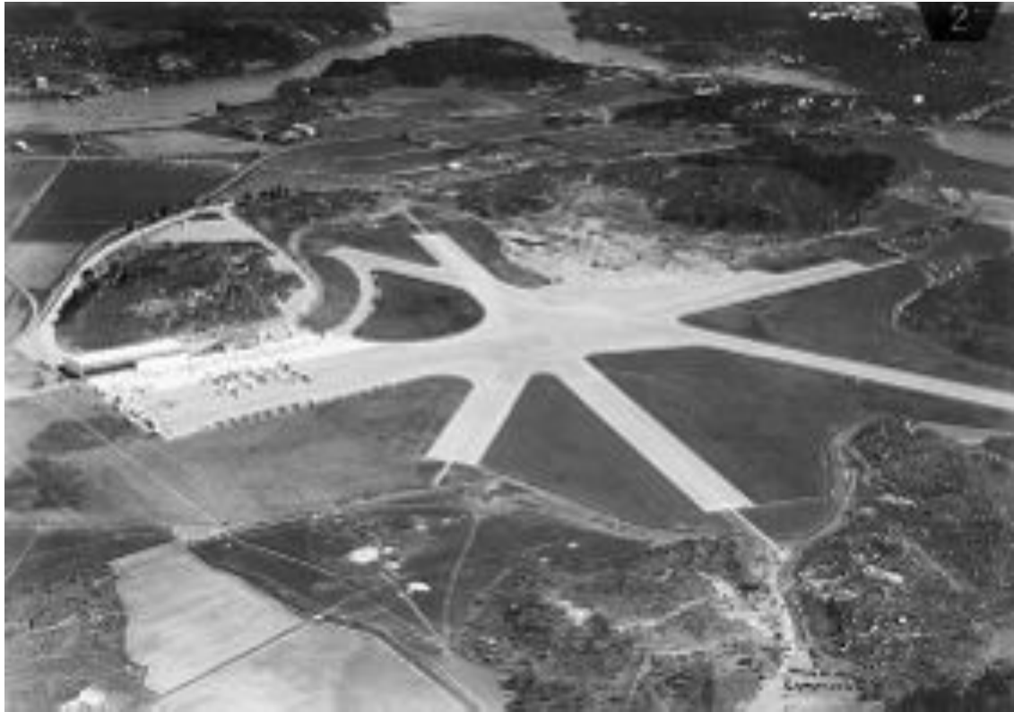
Bild 18: Bromma flygplats, flygbild från 24 maj 1936, dagen efter invigningen. Stationsbyggnad och hangar i läge nära Ranhammarshöjden är färdiga. Mängder av flygplan uppställda inför uppvisningarna. De nybelagda banorna syns tydligt. Arbeten med delar av bansystemet pågår dock fortfarande. Foto: Ahrenbergflyg AB.
