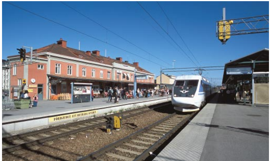
Ett snabbtåg från Stockholm anländer till Eskilstuna 2002. Stationshuset har fått behålla sin funktion i det nya resecentrumet som stod färdigt till Svealandsbanans invigning 1997.
