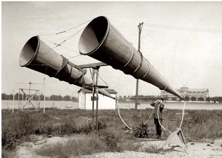
Figur 3. Akustisk radar, Bolling Field, USA, 1921.
