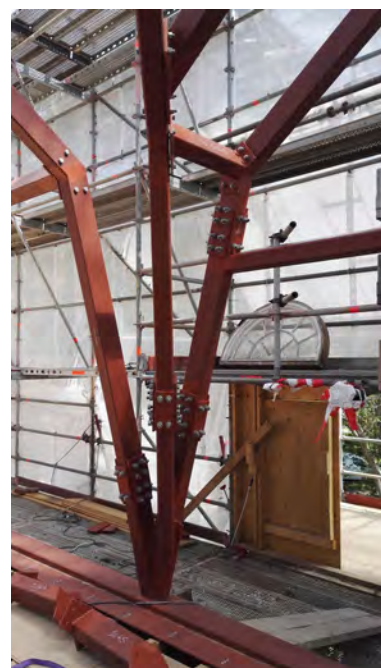
Komplicerade skruvförband från modell ovan.
