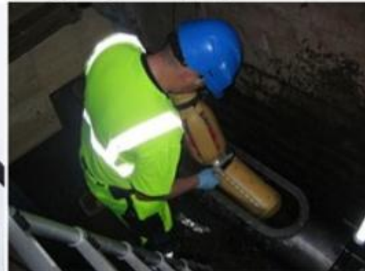
Innføring av pipescanner i vannrøret
