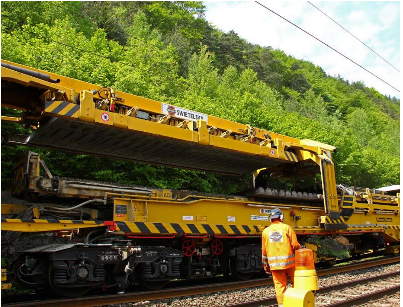
Kranen lämnar nya sliprar och hämtar gamla sliprar.
