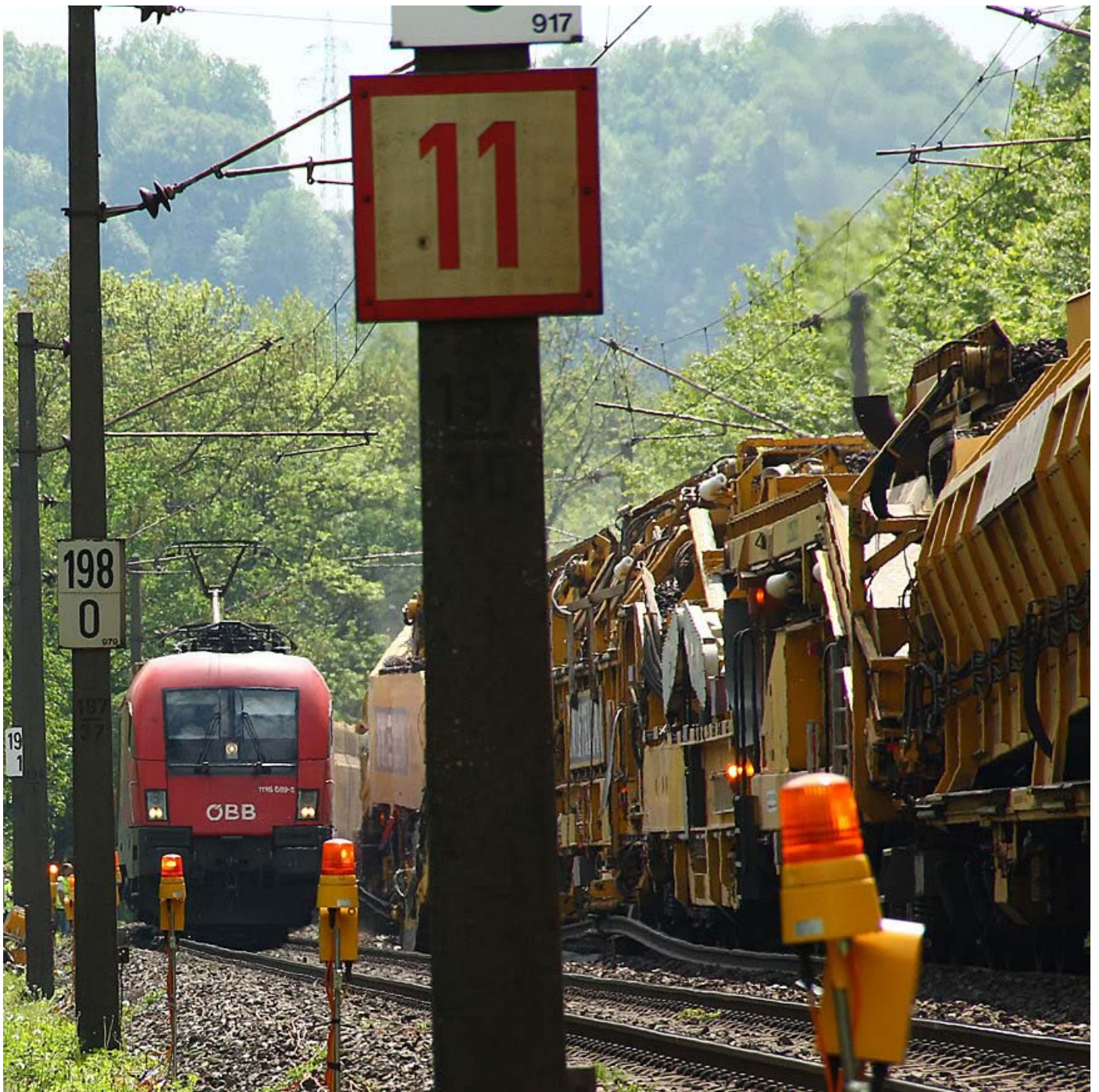
Ytterligare ett tåg passerar arbetsplatsen.
