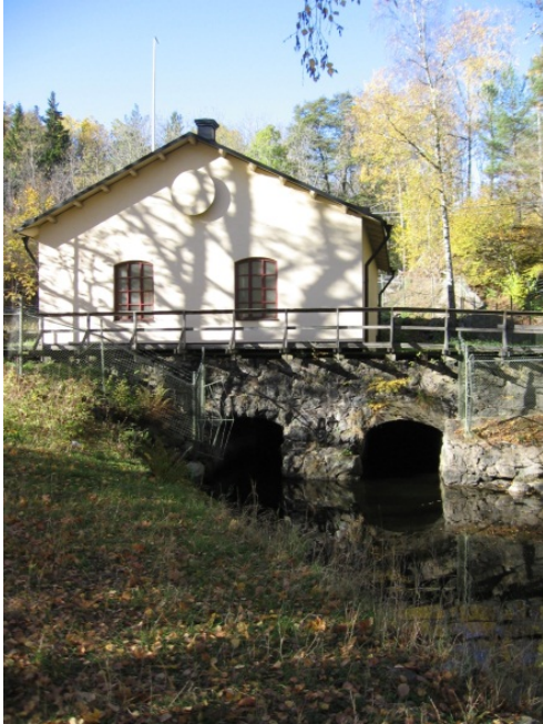
Uddby Hydro Power Plant, Tyresö
